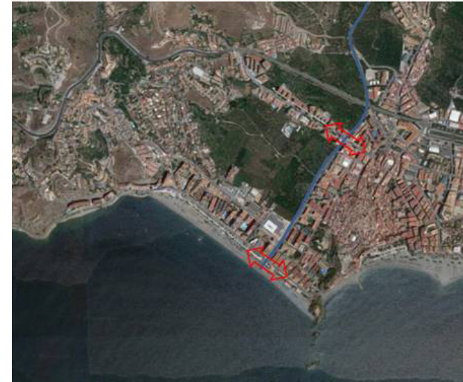
Deficiencias en la conectividad urbana en la zona de La Sandovala. Se representan los dos únicos enlaces en suelo urbano existentes entre los tejidos consolidados al este y oeste del cauce del Río Seco.
