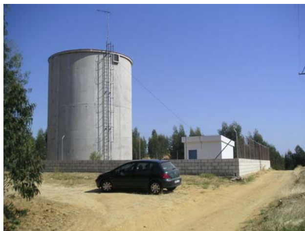
FOTOGRAFÍA III-20: Depósito intermedio de Manzanilla y grupo de bombeo
