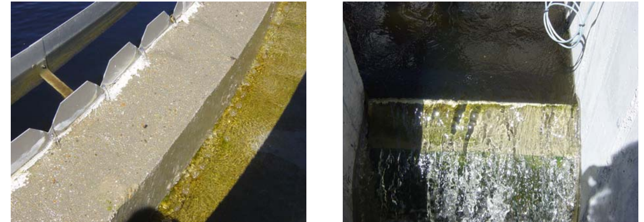
FOTOGRAFÍA III-39 Y 40: Aireación y vertido
