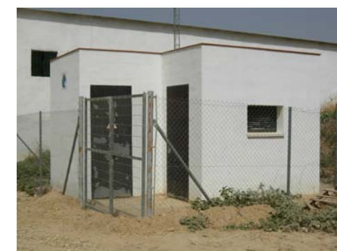
FOTOGRAFÍA III-34: Estación de Bombeo junto a gasolinera de carretera a Tujena
