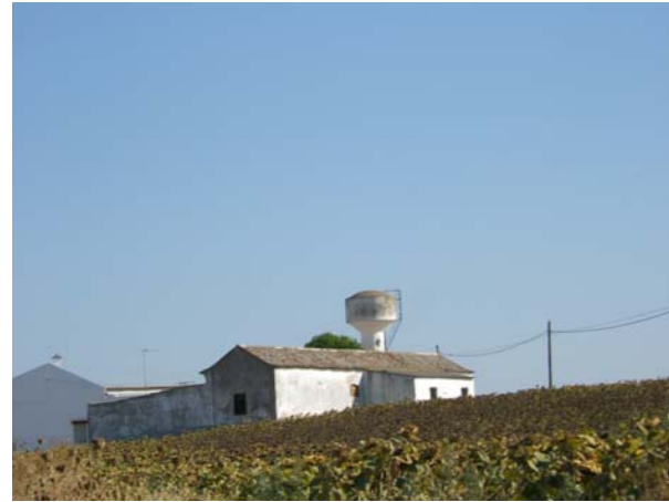
FOTOGRAFÍA III-24: Depósitos del municipio de Paterna del Campo, situados al sureste de la población
