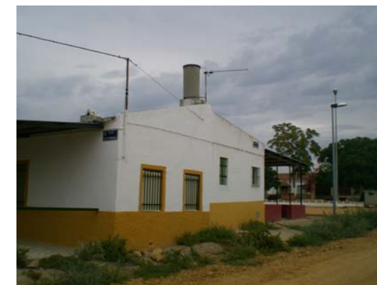
FOTOGRAFÍA III-27: Depósito particular de un vecino de Tujena
