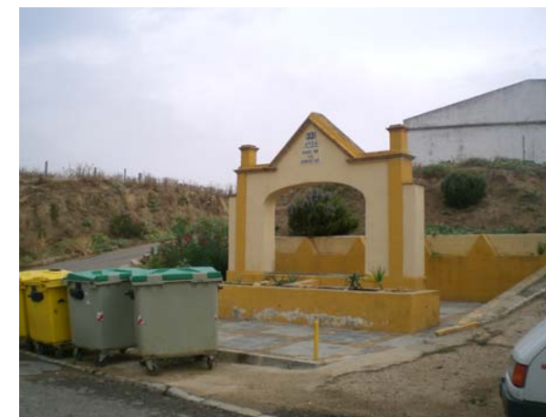
FOTOGRAFÍA III-13: Pozo de la Libertad en la calle San Roque
