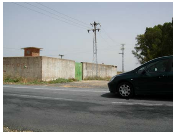
FOTOGRAFÍA III-15: Pozos de captación junto al Puente Zancudo
