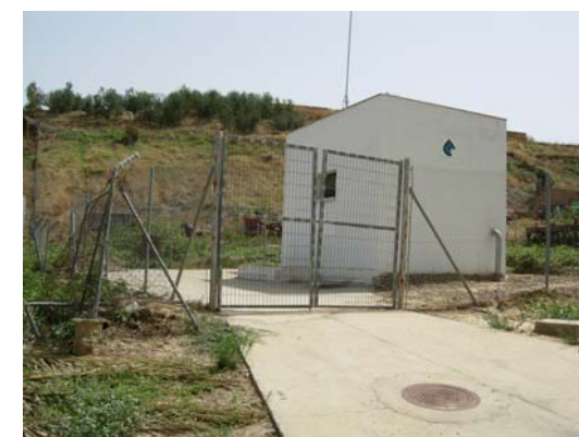
FOTOGRAFÍA III-33: Estación de Bombeo junto a El Pinguete.
