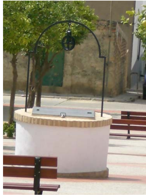
FOTOGRAFÍA III-14: Pozo de captación en la calle Antonio Machado
