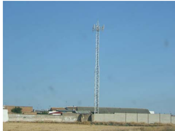
FOTOGRAFÍA III-62: Antena de repetición en calle Lagunilla
