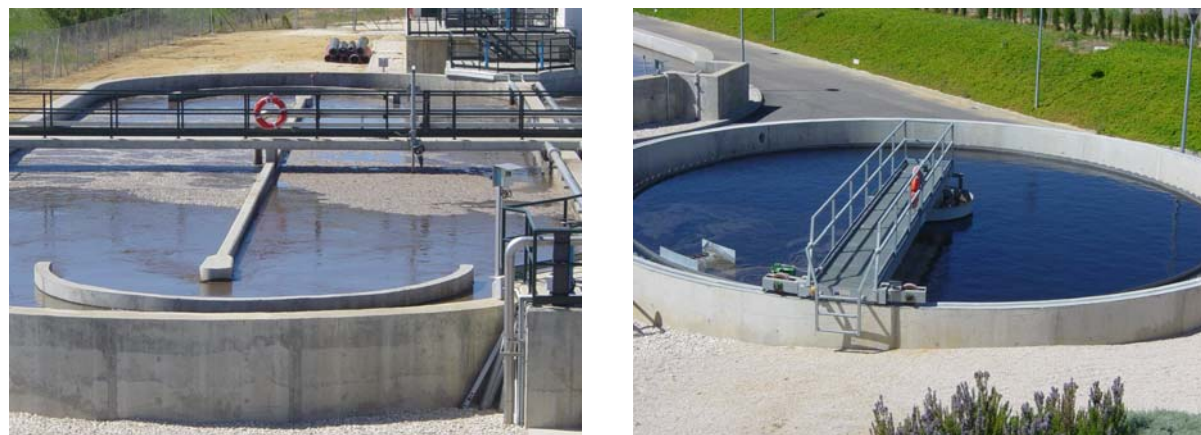
FOTOGRAFÍA III-37 Y 38: Pretratamiento y tratamiento secundario
