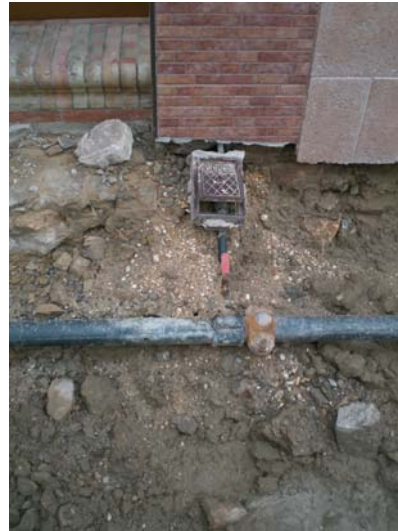
FOTOGRAFÍA III-64: Nueva acometida a vivienda en la Avda. de la Libertad.
