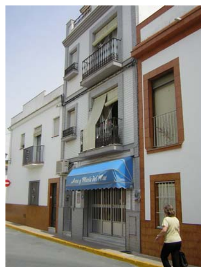
FOTOGRAFÍA III-10: Ejemplo de edificación plurifamiliar dentro del Núcleo Histórico
