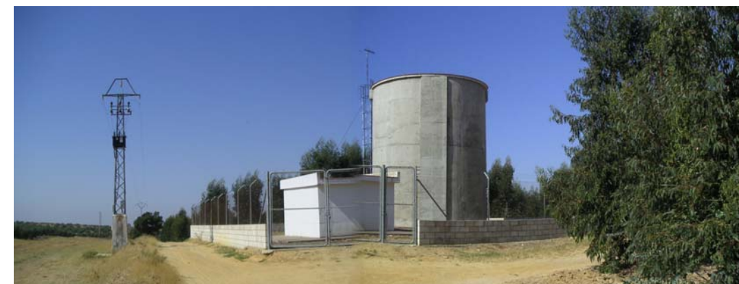
FOTOGRAFÍA III-23: Depósito secundario situado en el Término Municipal de Manzanilla
