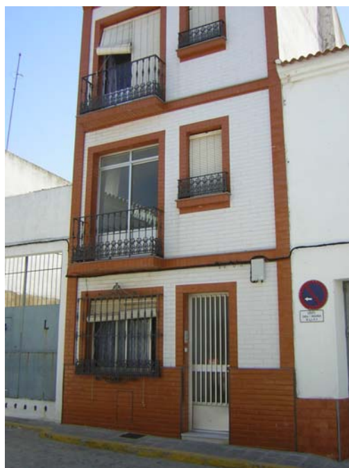
FOTOGRAFÍA III-7: Ejemplo de edificaciones con altura de P.B. + 2 dentro del Núcleo Histórico
