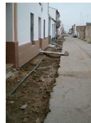
FOTOGRAFÍA III-28: Obras de mejora de la red en Avda. Libertad
