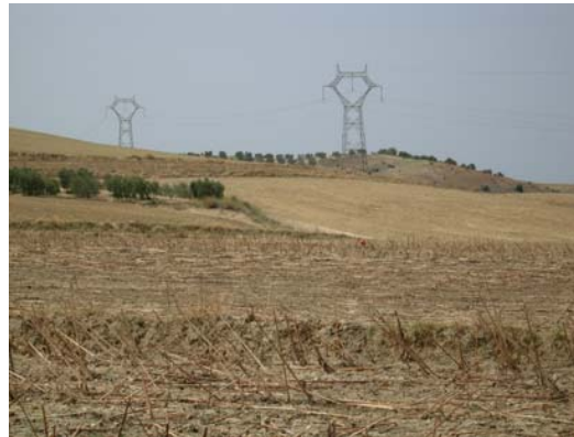
FOTOGRAFÍA III-70: Impacto visual de la red de 400kV de R.E.E.
