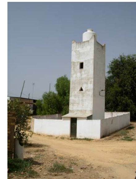
FOTOGRAFÍA III-26: Depósito de almacenamiento y regulación de la aldea de “Tujena”
