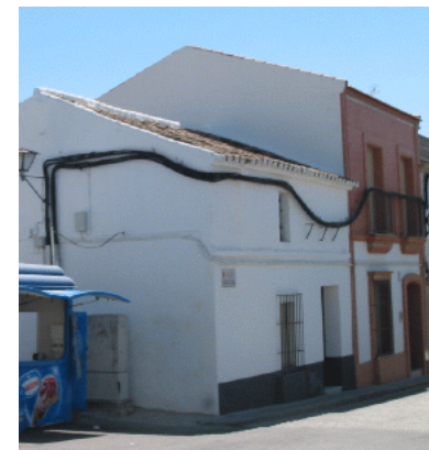
Infraestructuras generalizadas en fachada
