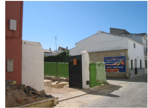
Ruptura de alineaciones y ocupación de interior de manzana en C/ Las Pajas
