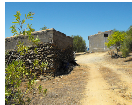
Ruinas de la Casa de la Botija
