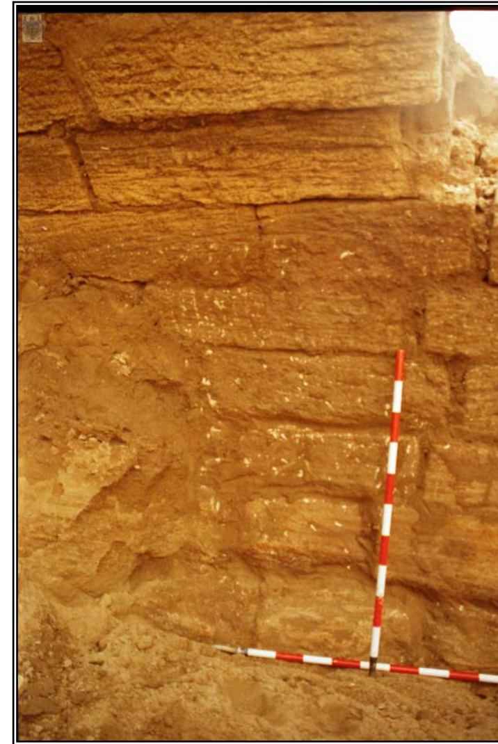
Detalle del interior del puente.
