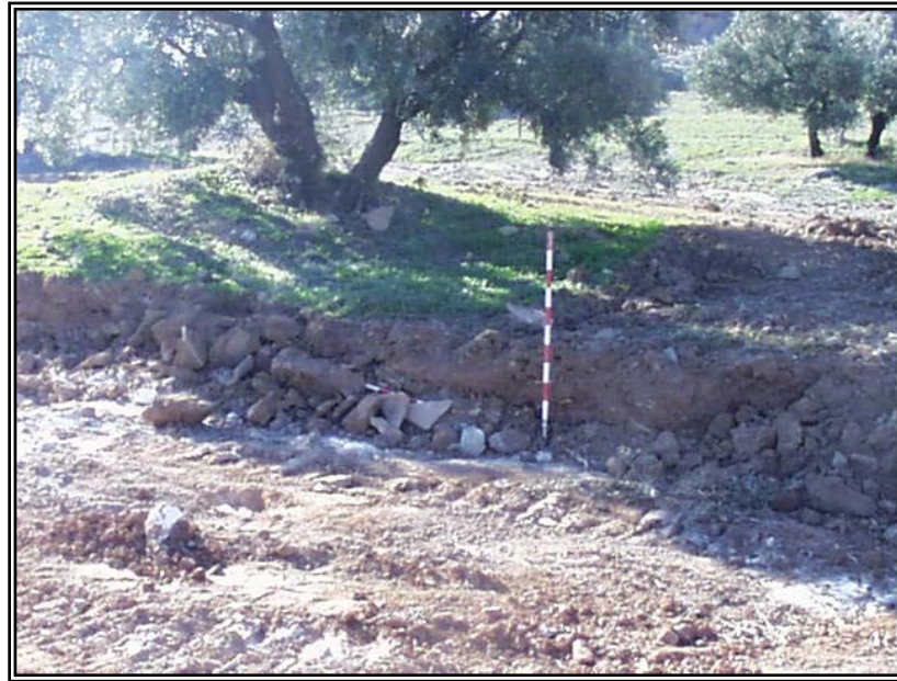
Las perdices-01: Perfil resultante tras los trabajos de desbroce realizados en las obras del gasoducto.
