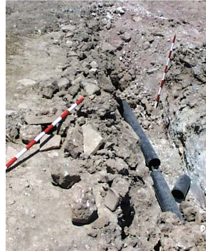
Restos de téglulas y materiales cerámicos procedentes de La canalización.
